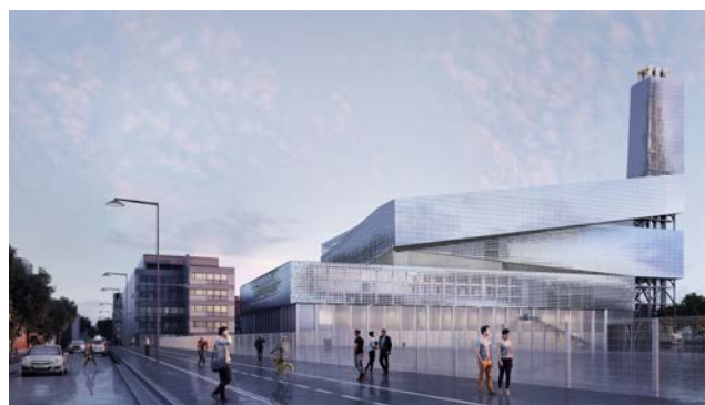
▲ Vue depuis rue Mitterand.
