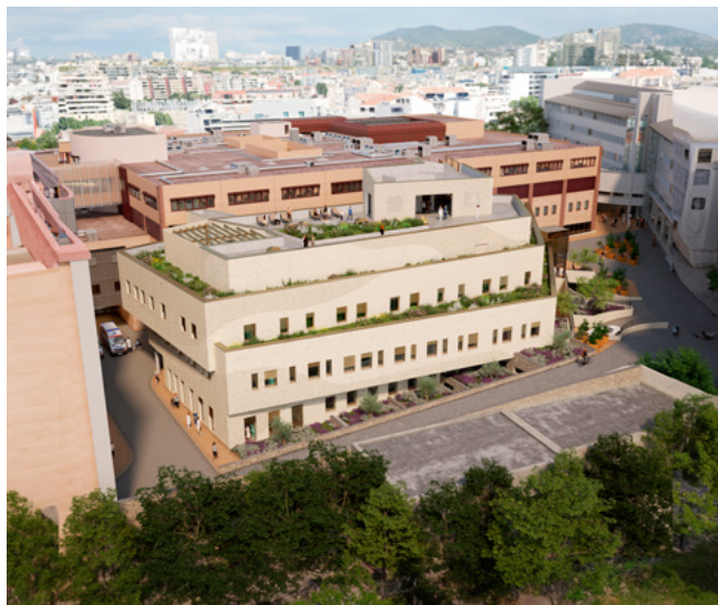
▲ Vue extension Sud.
