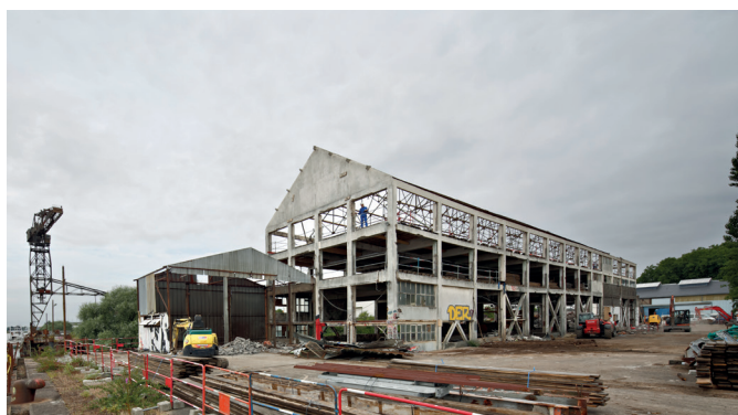
▲ Salle à Tracer avant travaux
