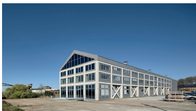
▲ Salle à Tracer après travaux
