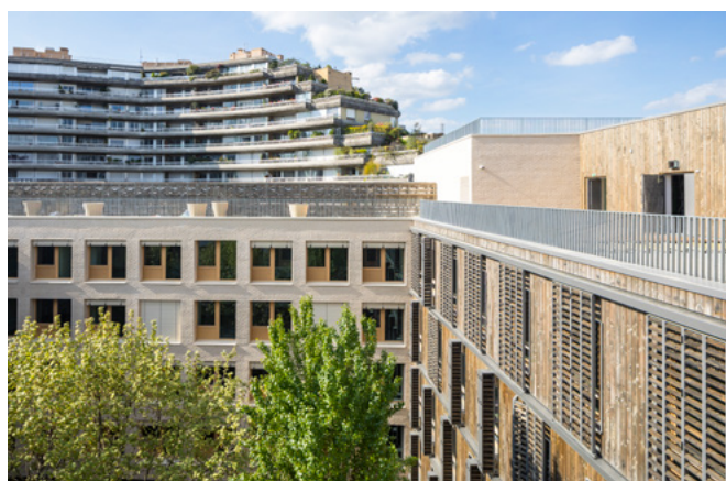
▲ Vue depuis la toiture.
