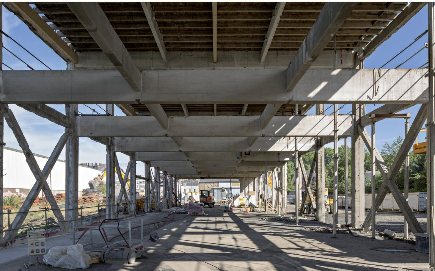
Le bâtiment est débarrassé de toutes ses scories inutiles pour ne conserver que l'essentiel, la structure porteuse béton, le plancher classé et la charpente métal.
