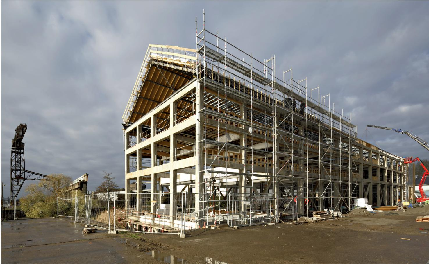
Après passage en atelier pour réparation (renfort, sablage et peinture), la charpente de toiture est réinstallée. Elle supporte désormais une enveloppe thermiquement performante habillée de zinc.
