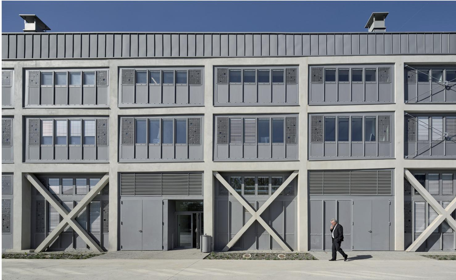
Le bâtiment lègue une succession de déformations assumées. Dans les alvéoles trapézoïdales viennent s'inscrire des ensembles menuisés préfabriqués dont la géométrie régulière souligne « l'anomalie ».
