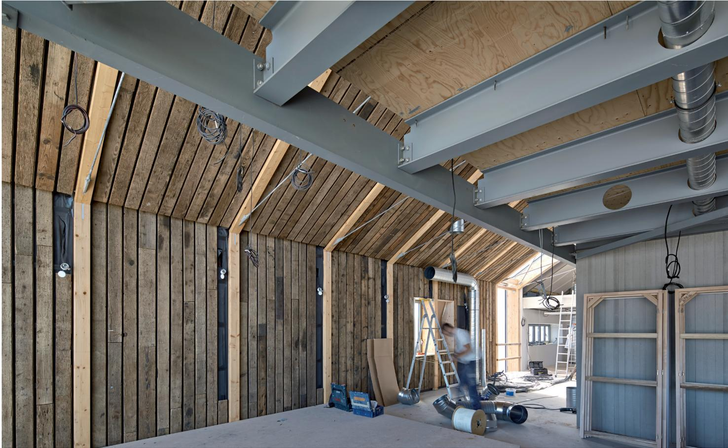
Poursuivant l'idée d'une plus grande frugalité constructive, le plancher du niveau +1 est recyclé. Nettoyé, il vient habiller le volume d'entrée et témoigner de la mémoire de la salle à tracer.
