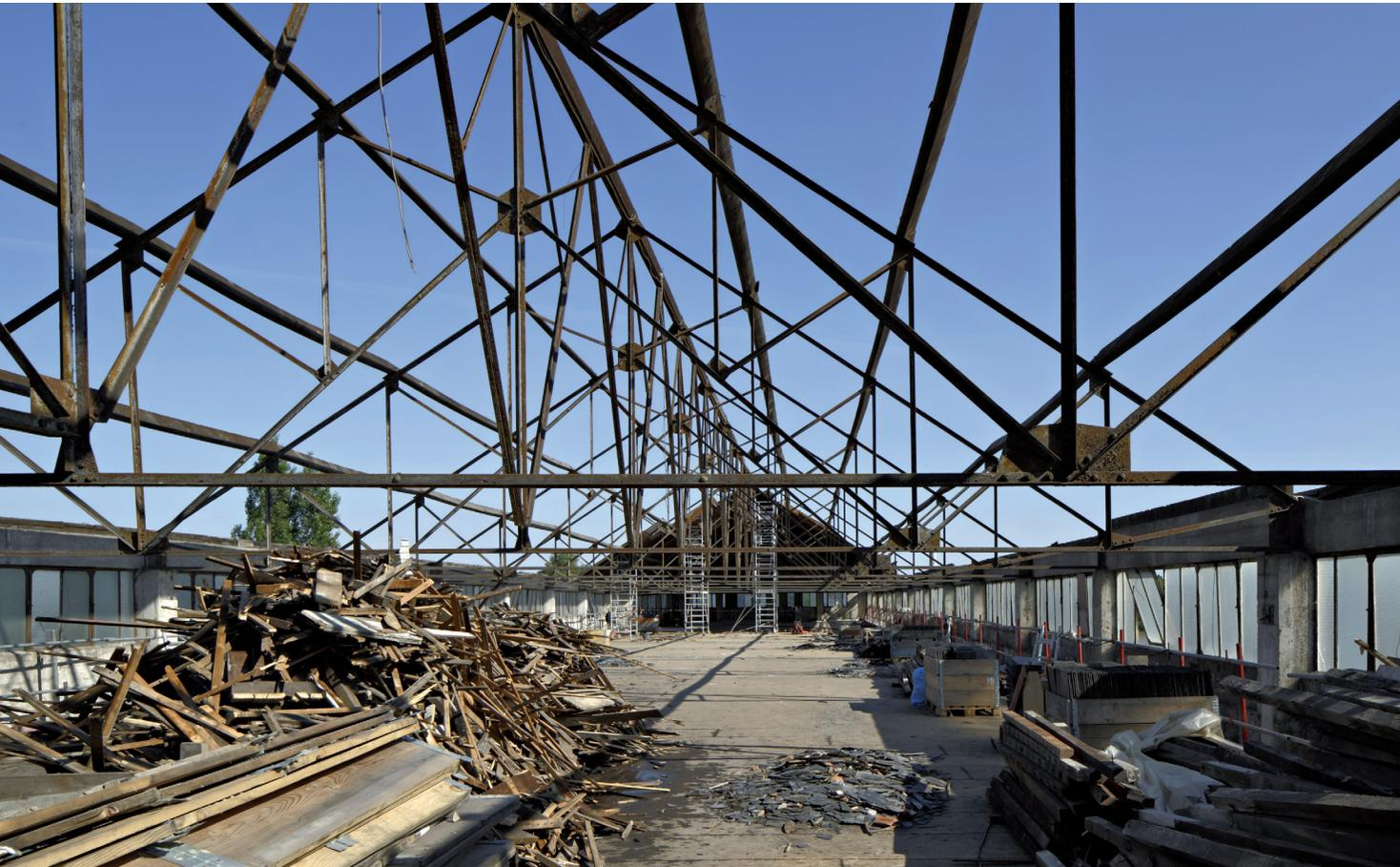
Le plancher de la salle à tracer est protégé des intempéries et du chantier. Les matériaux sont méthodiquement déposés et classés. Les ardoises de Trélazé vont connaître ailleurs, sur un autre site, une nouvelle vie.
