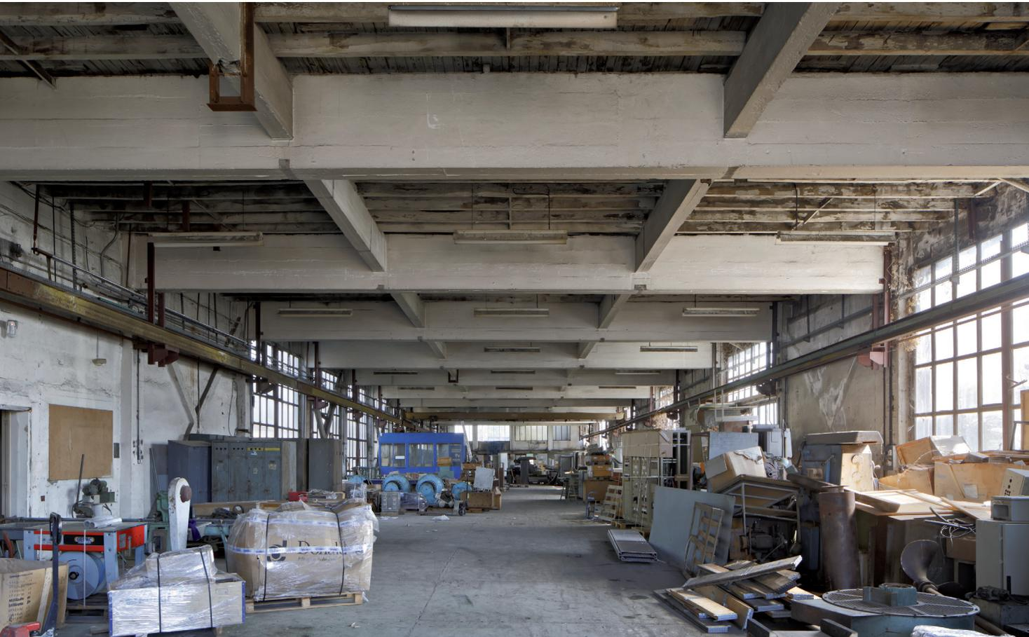
Réparti sur trois niveaux, l'intérieur révèle une construction mixte « avant-gardiste ». Béton pour la structure et bois pour les planchers sur solives.
